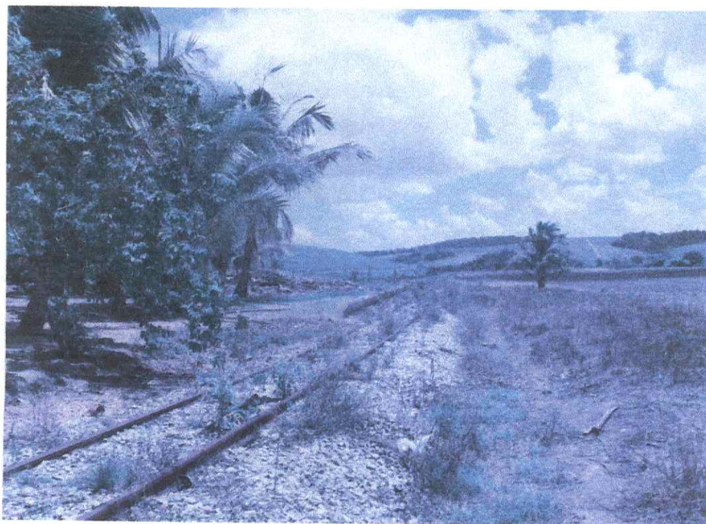
Foto 24 – Vista Panorâmica da Antiga Estação Mundaú – Limite de Rio Largo; Murici e Messias
